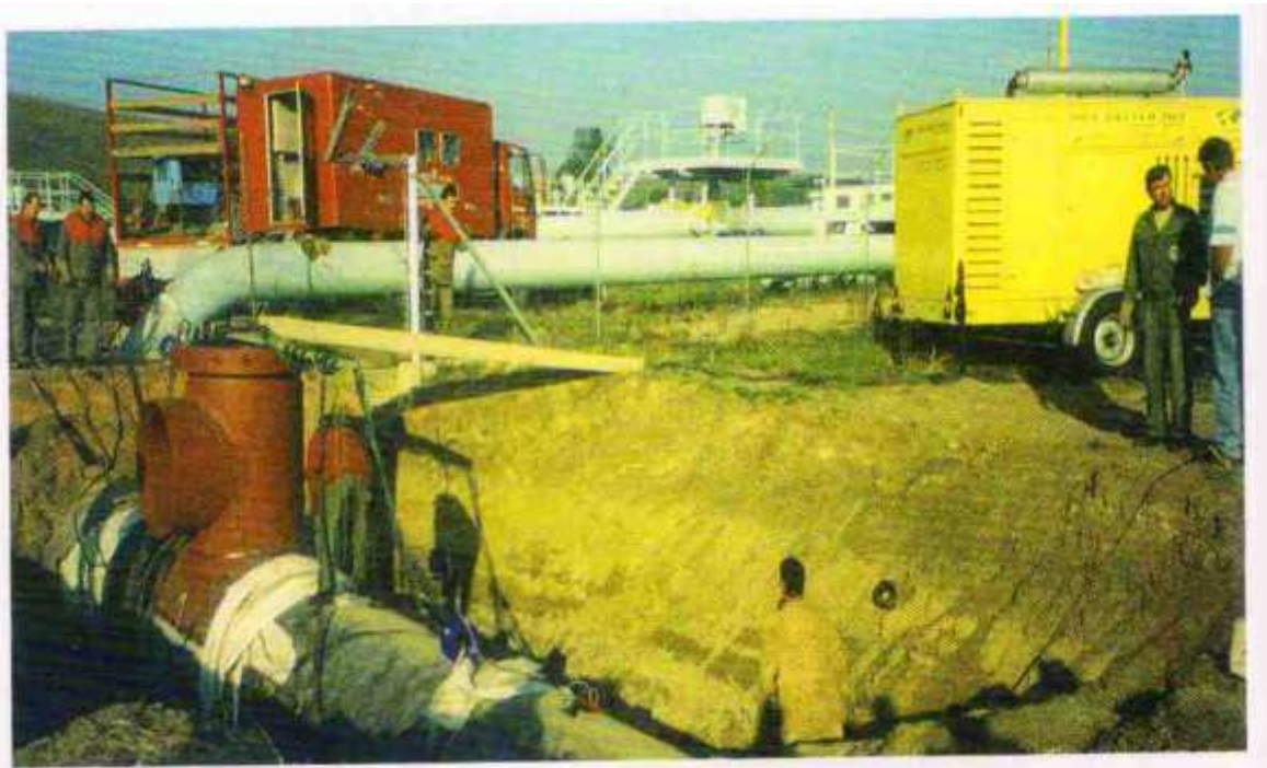
Surat77. Meýdan şertlerinde gyzdyryjy desganyň kömegi bilen gazly turbanyň gyzdyrylyşy
