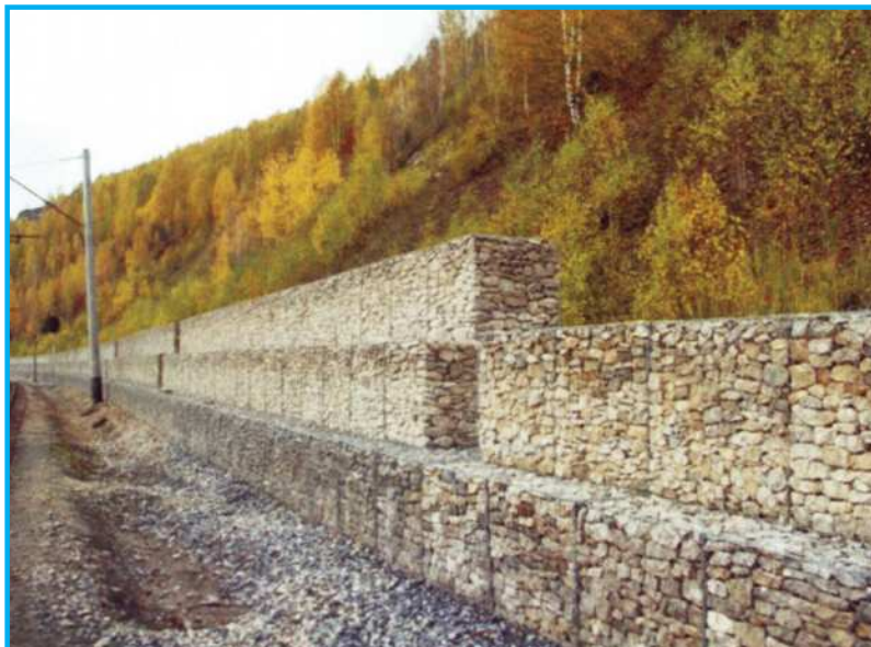
2-nji surat. Ýer örtüğini ýokardan gaçýan daşlardan goramak üçin gabion- dan bolan gurluşlar: a-öňki durky; b-abatlanandan soňky durky
