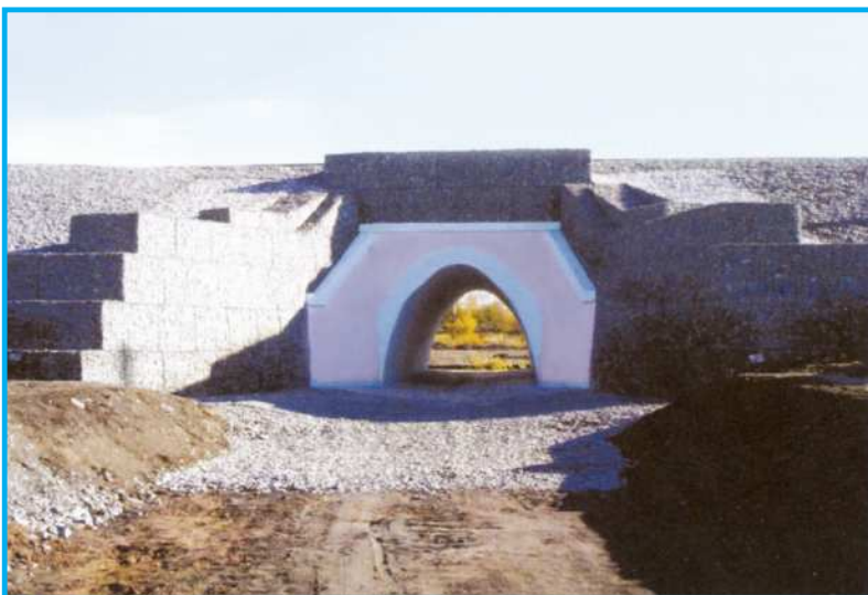
1-nji surat. Suw geçiriji desgalarda gabion gurluşlaryny ulanyp galdyrmanyň ýapgytlaryny düýpli abatlamagyň usullary:
